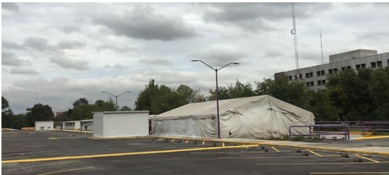
Segundo piso del Estacionamiento.
